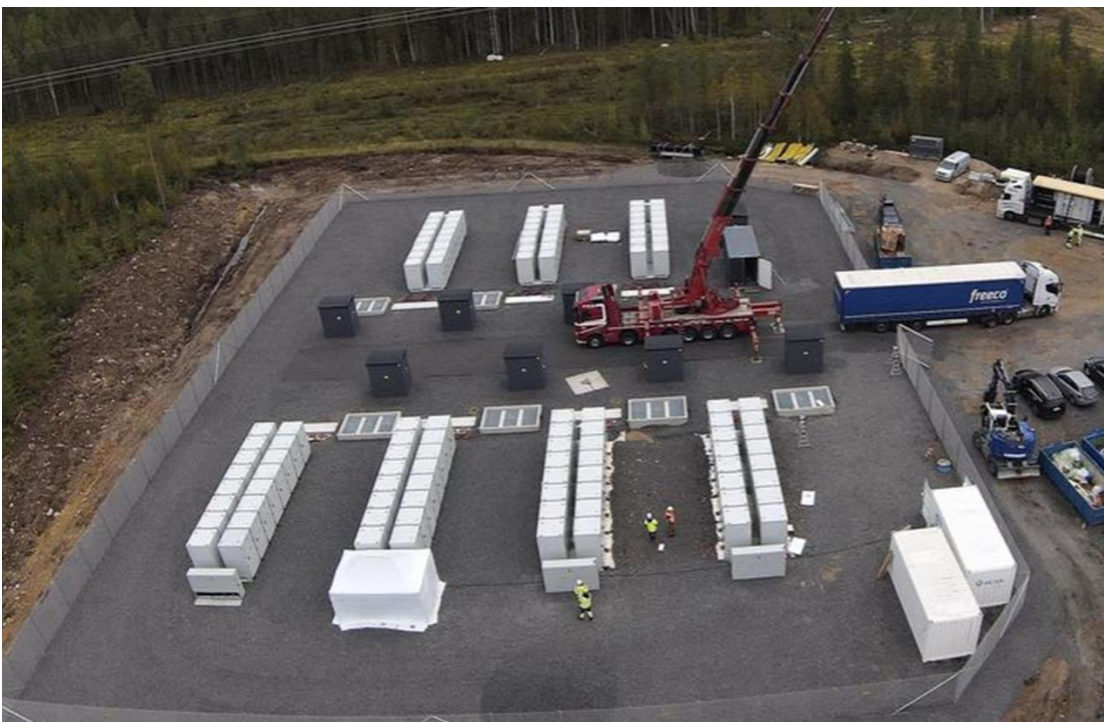
Kuva 7. Havainnekuva: Akkujärjestelmä rakentuu (Kuva: Kauppalehti)
